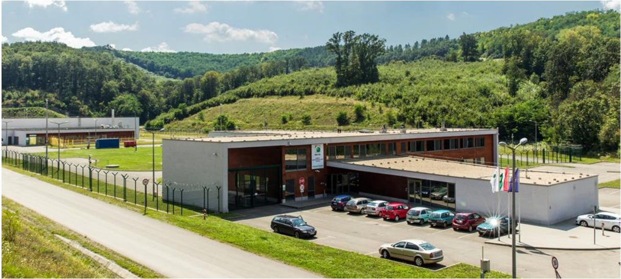
2. ábra: Bataapáti – Nemzeti Radioaktív Hulladéktároló
